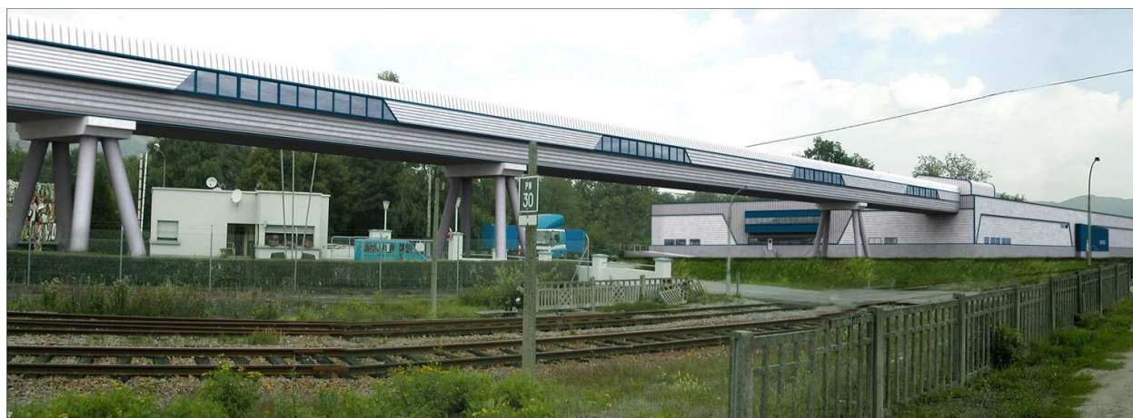
Chemin de roulement entre l'usine et l'entrepôt (©Rossmann)
